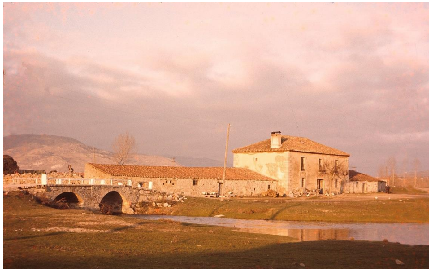
Fotografía del edificio de la Venta, en el que se aprecia el Puente de Piedra atravesado por el Arroyo de la Poveda, fue tomada a finales de los años 60.
